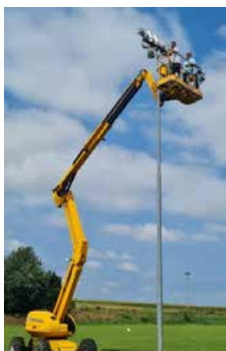
Montagearbeiten der neuen Flutlichtanlage – Erich Wejda und Karl-Heinz Mayer
